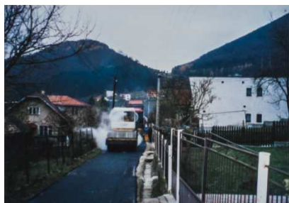
pokládka asfaltového koberca - Vráta r.2002
