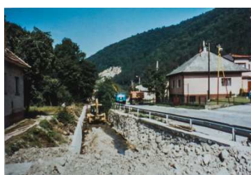
budovanie kanalizácie - stred obce | regulácia potoka č.d. 190
