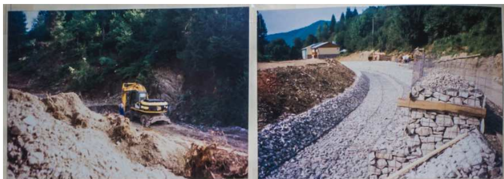
výstavba novej cesty - horný koniec dediny
